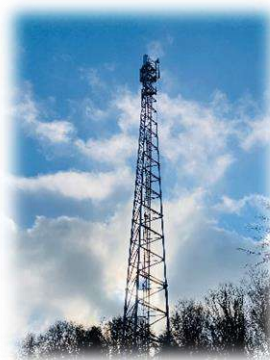
Mise en service de l'antenne relais en décembre 2022
