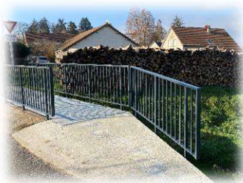
Installation de la passerelle PMR Rue de la marnière aux chiens
